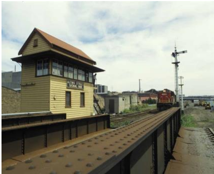
Ultimo signal box c 1984
